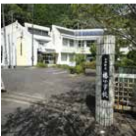
(廃校となった椿小学校)
