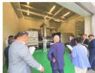
（平浄水場非常用発電機）
